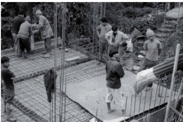
Konstruktionsarbeiten in Darjeeling
